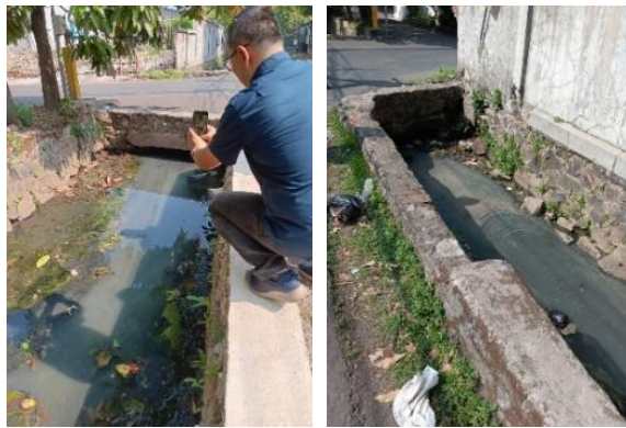
Gambar 16 Bottle neck pada node P10-P11 akibat sedimentasi
